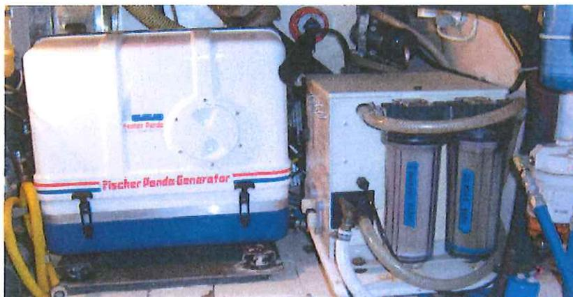
Groupe électrogène à gas-oil 6 Kw
